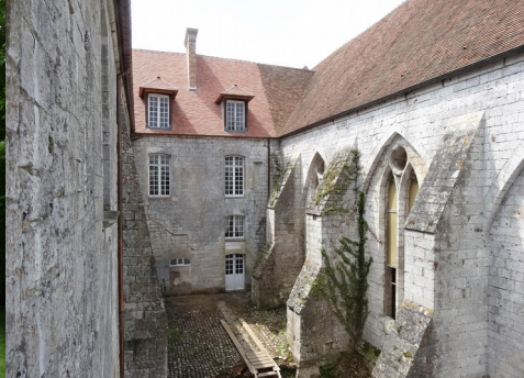
La vue vers la terrasse et le chauffoir
